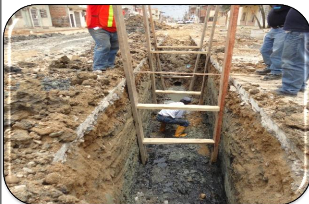
Reparacion de red en Calle Guayas
