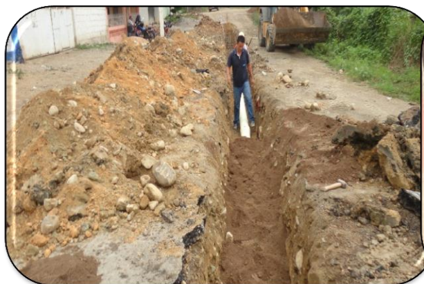
Ampliacion red principal Barrio Atahualpa
