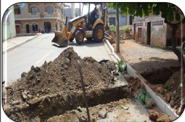
Reparacion de Tirante y Ampliacion de Terciaria Barrio Centenario
