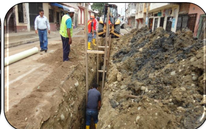
Mantenimiento red Principal Barrio Centenario
