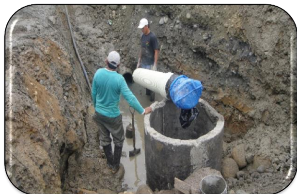
Reparación Red Principal Calle Teresa Arcaya y Zaruma
