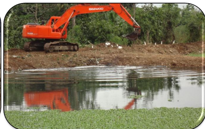
Limpieza de Lagunas de Oxidación
