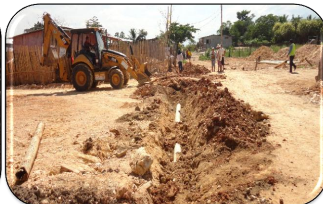
Reparación red terciaria Los Ceibos
