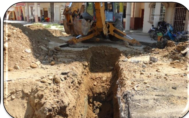
Reparación Tirante Calle Sucre y Jambeli
